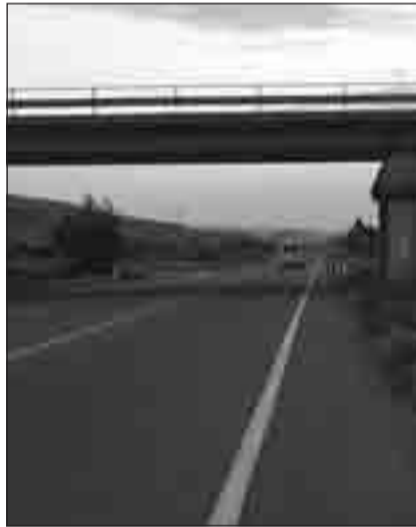
La strada statale Sinnica
